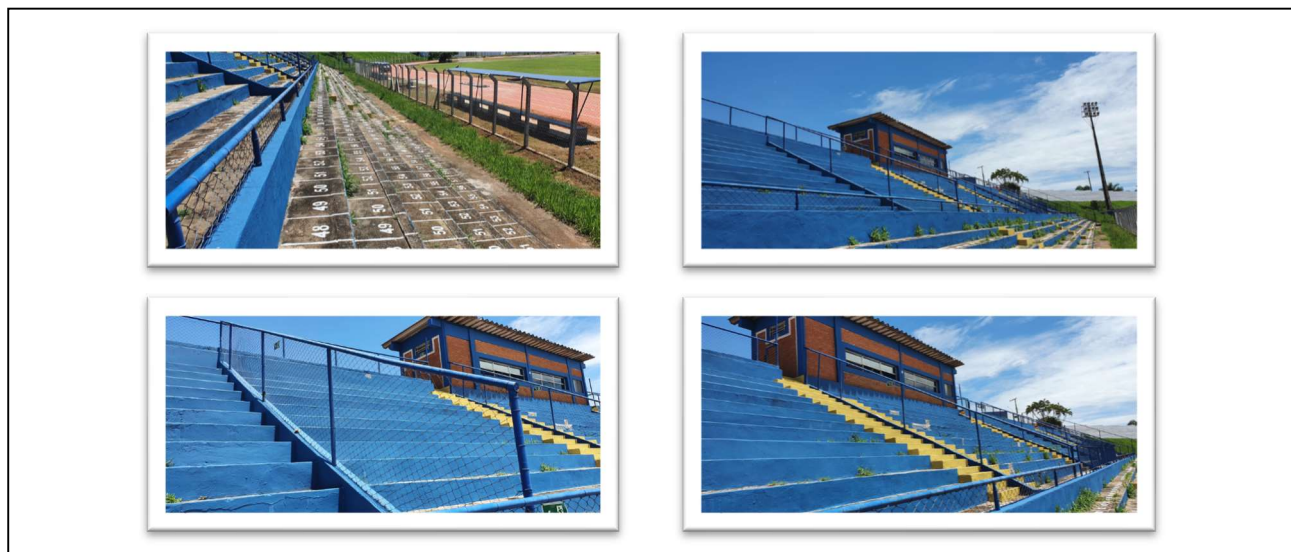
Fotos 55, 56, 57 e 58 – Detalhes dos guarda-corpos
