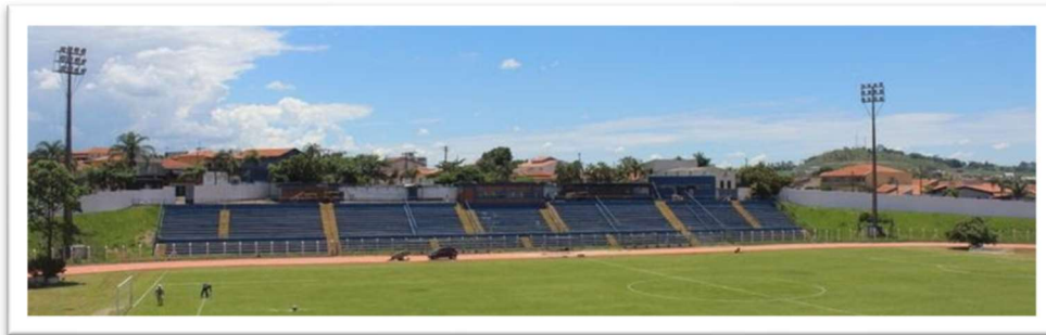
Foto: 236 – Arquibancadas - Torres 2 e 3
