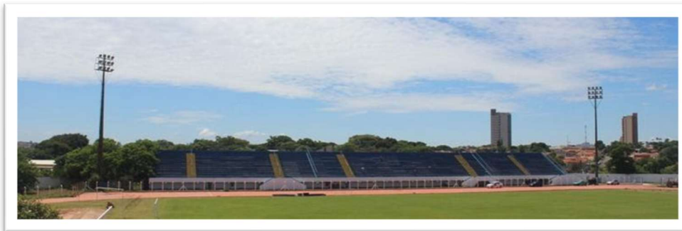
Foto: 235 – Arquibancadas - Torres 1 e 4
