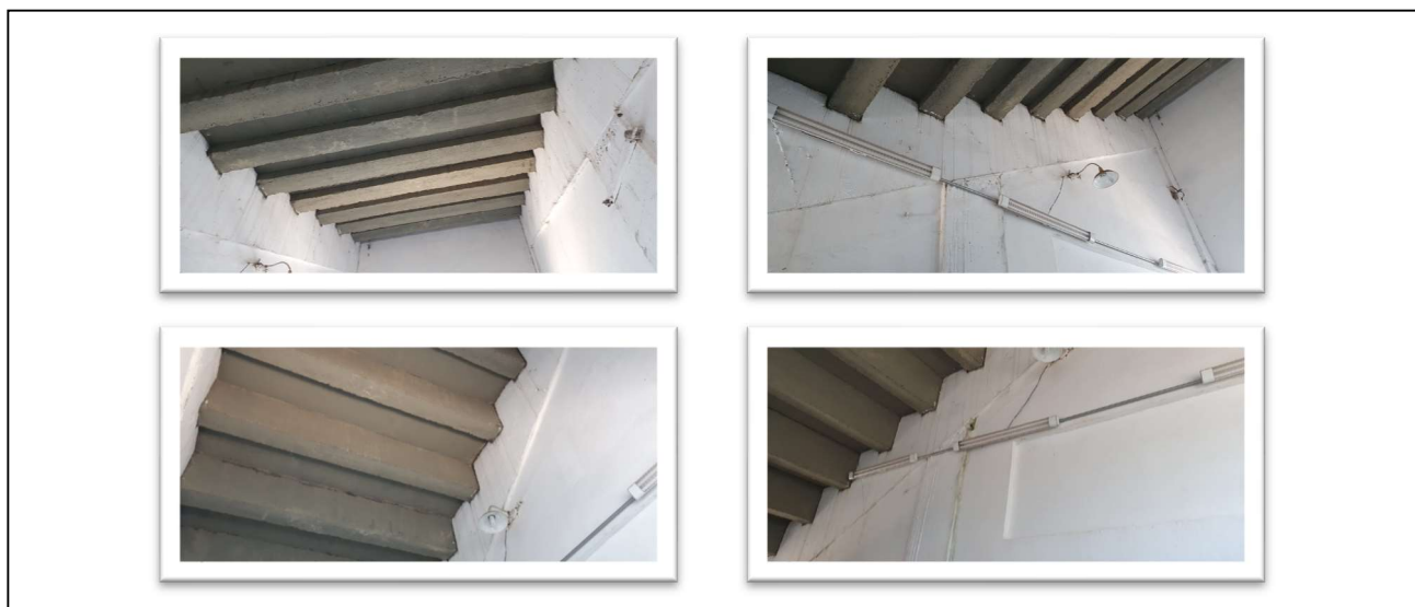
Fotos 5, 6, 7 e 8 – Detalhes da Estrutura da Arquibancada do Setor 1
