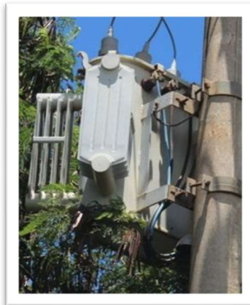
Foto: 96 - Ferragens em condições satisfatórias
