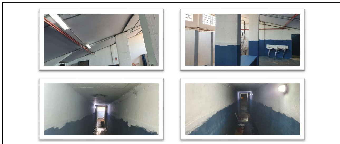
Foto 17, 18, 19 e 20 – Lajes e paredes sem manchas de infiltração
