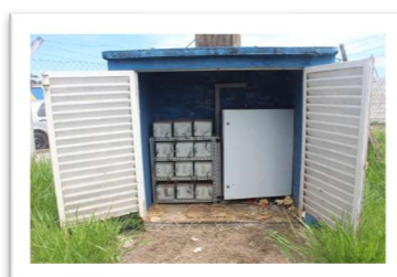
Fotos: 183 a 186 – Quadro de Iluminação Torre 1
