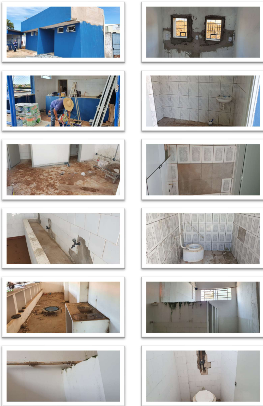
Fotos 37 a 48 – Paredes precisando de regularização e necessário limpeza – Edificação dos sanitários do Setor 3; Bilheteria do Setor 3, Lanchonete do Setor 2; Sanitário PNE masculino do Setor 2; Sala do VAR; Sanitário da Sala do VAR; Sanitário feminino do Setor 2 – área das pias; Sanitário PNE feminino do Setor 2; Lanchonete do Setor 1; Sanitário Feminino do Setor 1 e Sanitário Masculino do Setor 1 (fotos 47 e 48)
