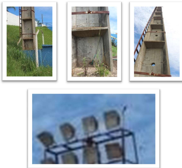
Fotos: 223 a 226 – Quadro de Iluminação Torre 2
