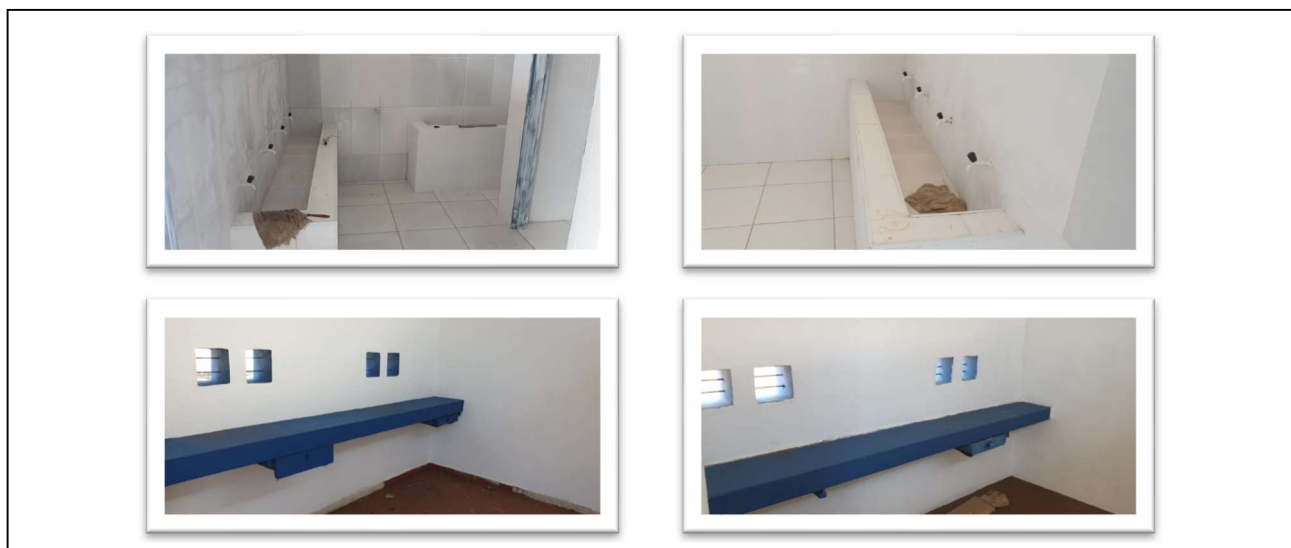
Fotos 25, 26, 27 e 28 – Paredes do sanitário masculino – Setor 3; Paredes do Sanitário Feminino – Setor 3; Paredes da Bilheteria do Setor 2; Paredes da Bilheteria do Setor 1
