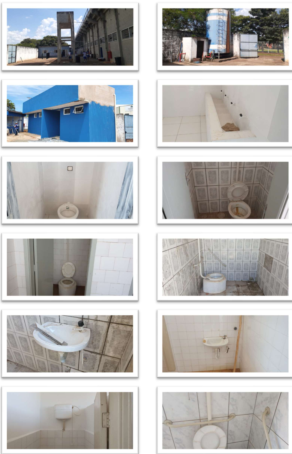
Fotos 59 a 70 – Reservatório de água de 10.000 l; Reservatório de água de 25.000 l; Tubo de descida de água pluvial da edificação dos sanitários do setor 3; Calha da pia e torneiras do sanitário do Setor 3; Vaso sanitário do sanitário do Setor 3; Vaso sanitário do sanitário da Sala do VAR; Sanitário PNE feminino do Setor 2; Pia do sanitário PNE feminino do Setor 2; Pia do sanitário das cabines de Imprensa; Caixa de Descarga do sanitário das cabines de imprensa e Vaso sanitário do sanitário masculino PNE do Setor 2
