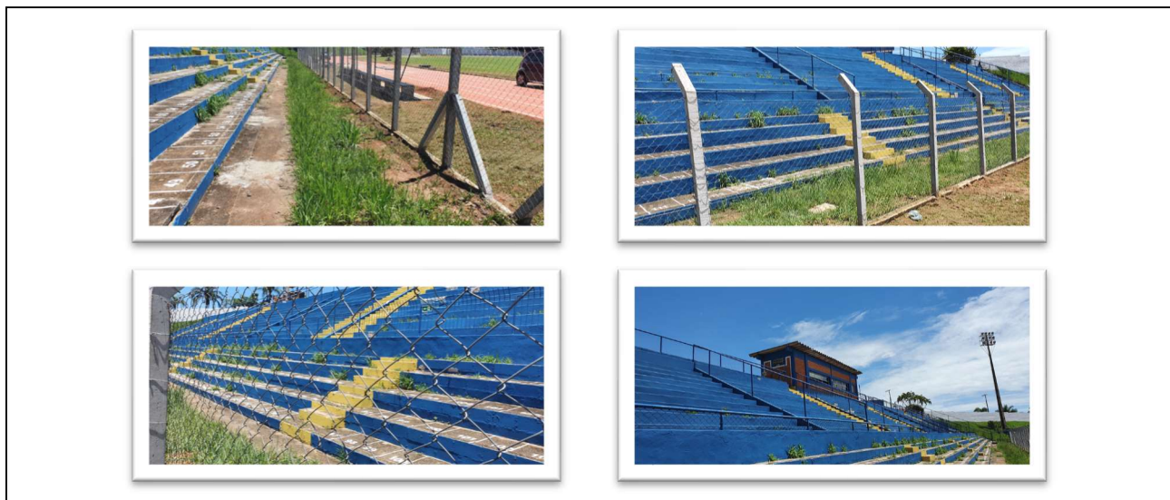
Fotos 13, 14, 15 e 16 – Presença de vegetação nos degraus da arquibancada
