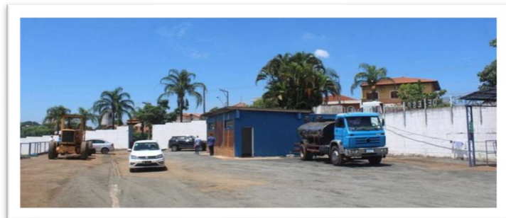
Fotos: 237 e 238 – Elementos Estruturais – Parte Alta – Setores 2 e 3
