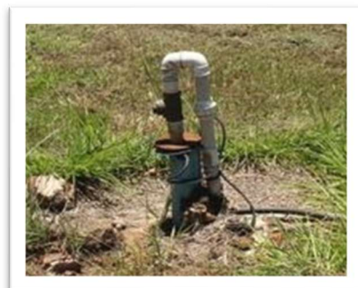
Fotos: 164 a 166 – Bomba Poço Artesiano
