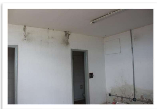
Foto 211 – Iluminação de Emergência – Sala do VAR
