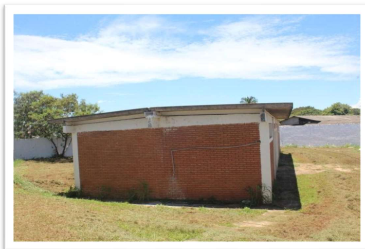
Fotos: 239 e 240– Elementos Estruturais – Vestiário dos Árbitros.
