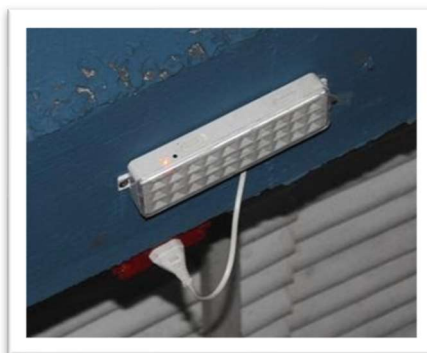
Foto 214 – Iluminação de Emergência – Alojamento
