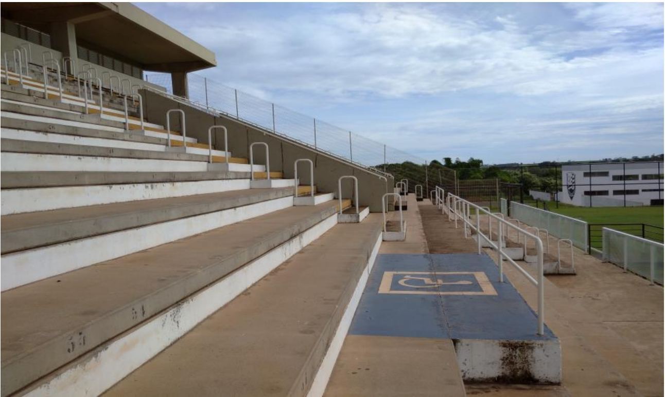
Foto 13 - Detalhe de espaços destinados à acessibilidade.
