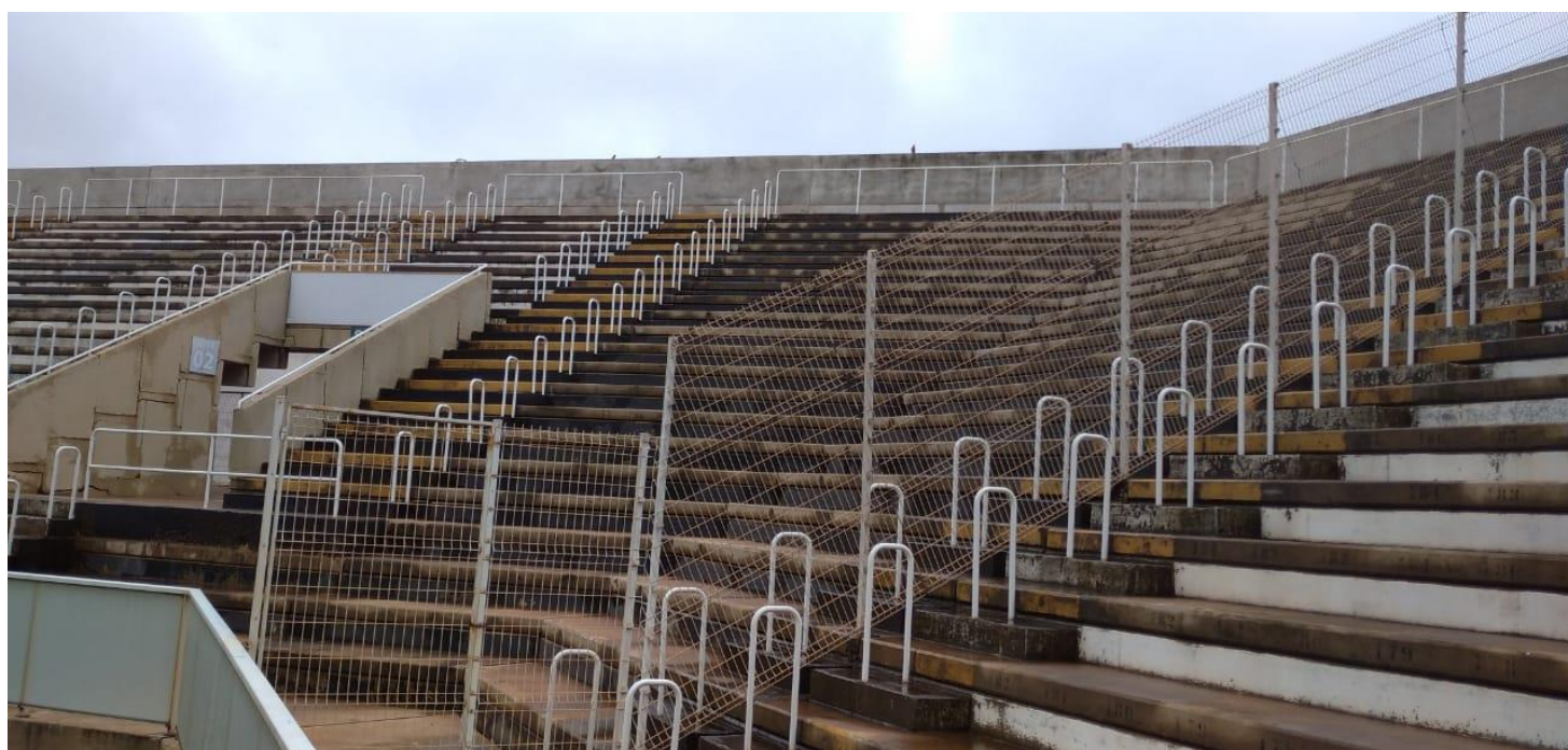
Foto 6 - Vista da junção da arquibancada lado oeste e sul ("curva" da arquibancada), com corrimãos, degraus de apoio, guarda corpos, e gradil de separação de torcidas. Entre o Setor 1 e 2.
