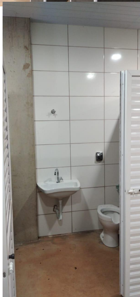
Foto 8 – Todos os banheiros tem instalações de acessibilidade.
