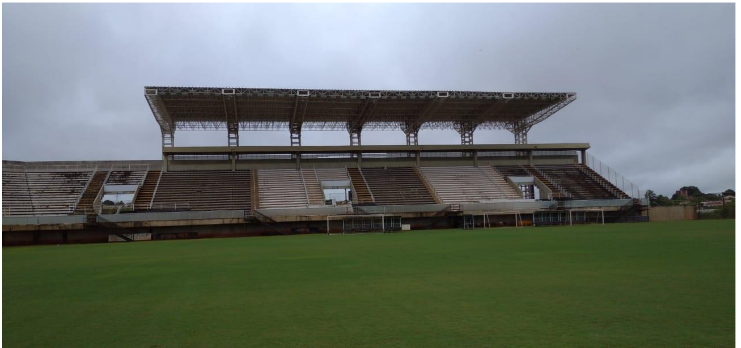
Foto 3 - Vista da arquibancada lado oeste (Setor 1) , parcialmente coberta .
