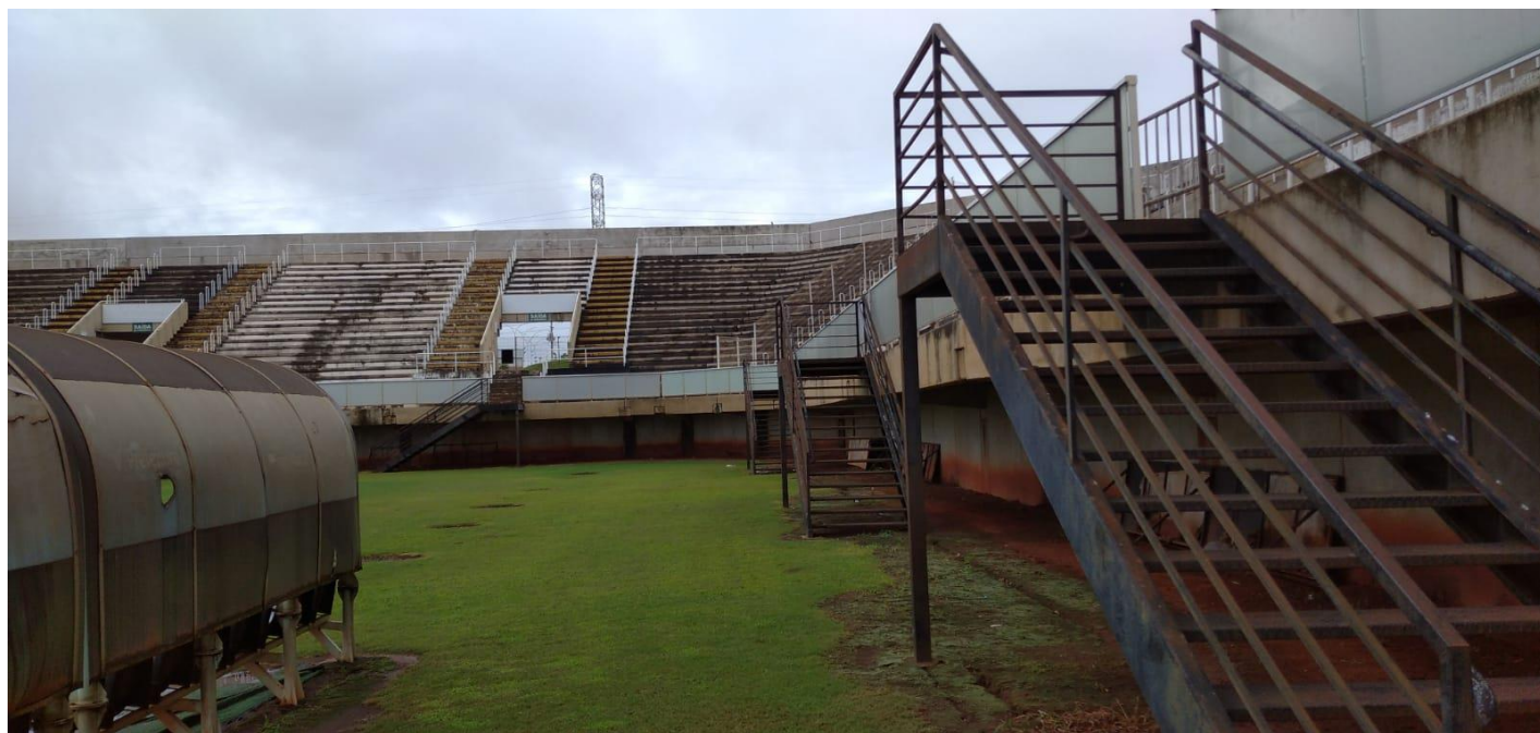
Foto 5 - Vista da arquibancada lado oeste, guarda corpos, escadas de rota de fuga para dentro do gramado, ao longo de todo o perímetro das arquibancadas. À esquerda cobertura de proteção dos jogadores reserva.
