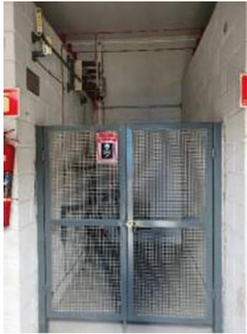
Figura 2: Cabine Principal - Sinalização de perigo bem localizada.
