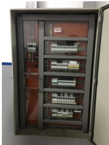
FIGURA 97 - QUADRO SUBSOLO 1 - ESTACIONAMENTO - SETOR A
