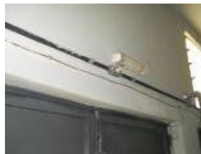
Figura 47: Iluminação insuficiente junto à cabine.
