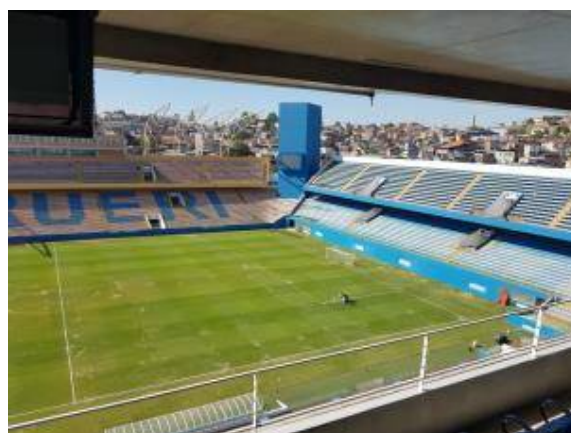
Figura 79A68: Arquibancada descoberta - Setor D - Localizado entre as torres 2 e 3 - Verificação da área de cobertura do SPDA.
