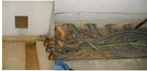
Figura 50: Cabine secundária: Leito de cabos em boas condições de instalação. Apresenta necessidade de melhorias junto ao piso da cabine
