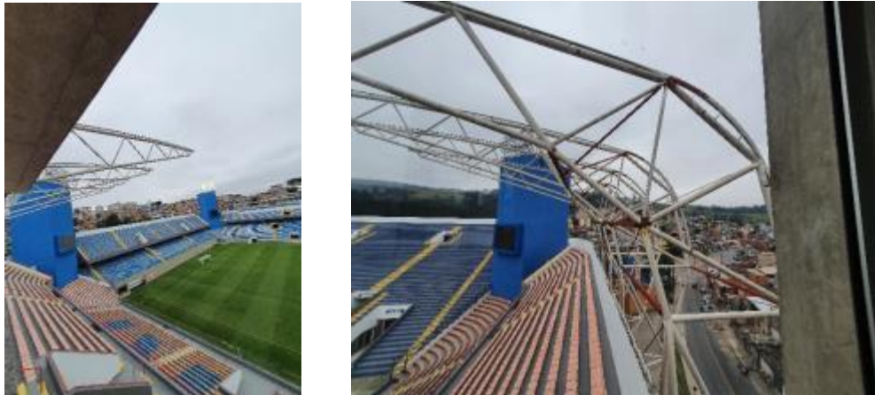
Figura 41 – Arquibancadas e guarda-corpo
