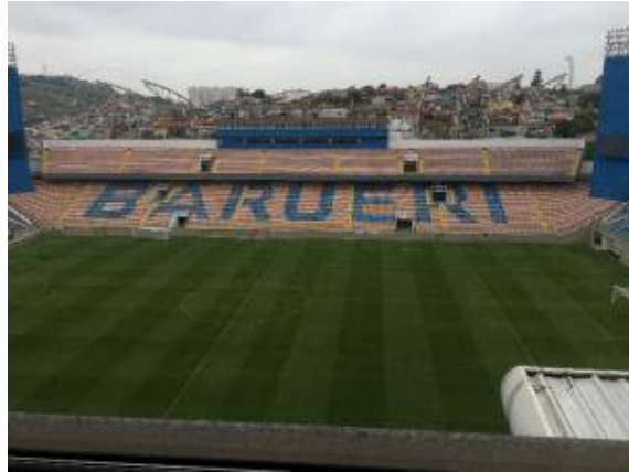
Figura 69: Estruturas metálicas de cobertura e tribuna de honra – Setor C - Estrutura de iluminação - Verificação do sistema de SPDA.
