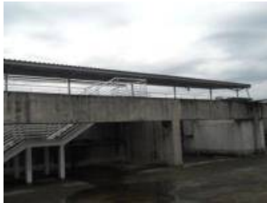
Figura 71: Estrutura metálica - Setor A - Verificação do Sistema de SPDA.
