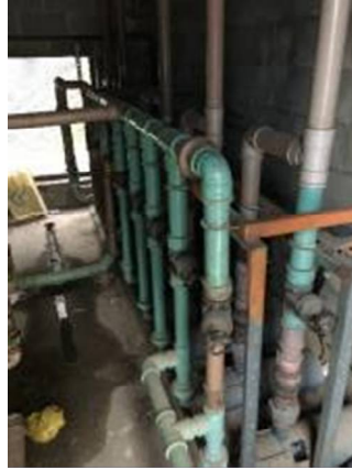
Figura 23: Casa de bombas: Local em bom estado. Necessita de poucas melhorias junto ao leito de cabos das eletrocalhas.
