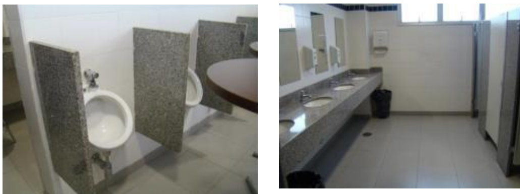
Figura 55 – sanitário setor c
