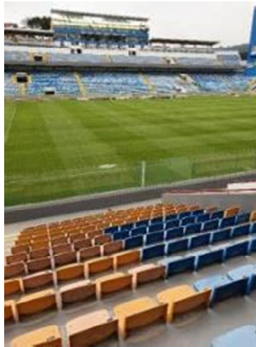
Figura 65: Setor A: Camarotes e setor VIP sem proteção SPDA.
