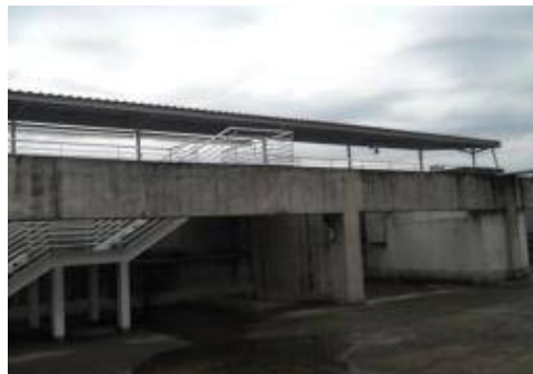
Figura 66: Cobertura do setor A.
