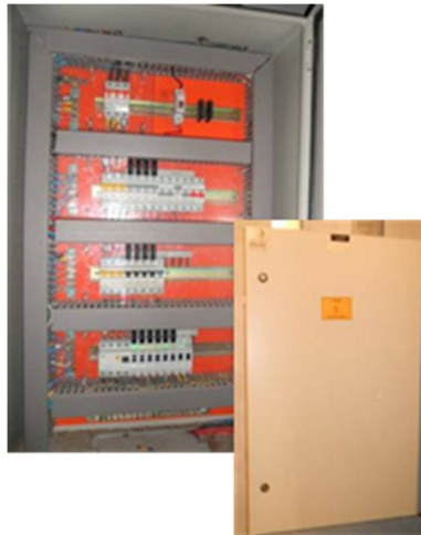
Figura 83: Quadro QTT AUDITÓRIOS E CAMAROTES: Quadro em boas condições de operação.
