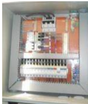
Figura 138: QLT - Bilheteria - Quadro em bom estado de conservação e instalação.
