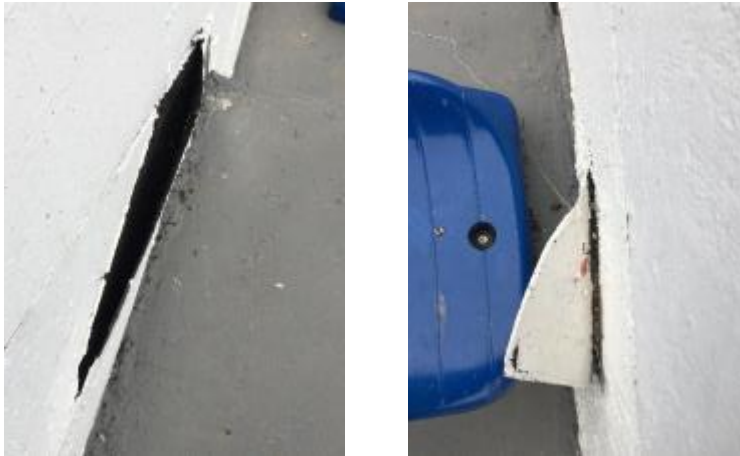
Figura 37 – Manta de impermeabilização.
