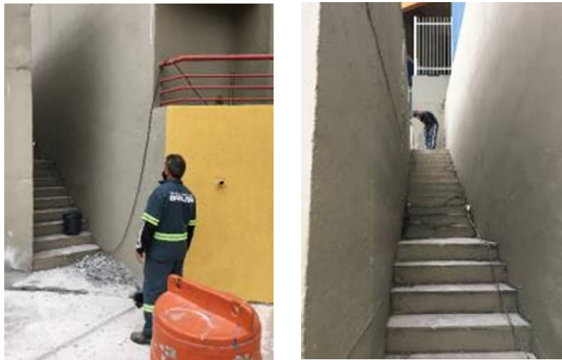
Figura 78B- Obras de manutenção do Sistema de Proteção contra Descargas Atmosféricas.
