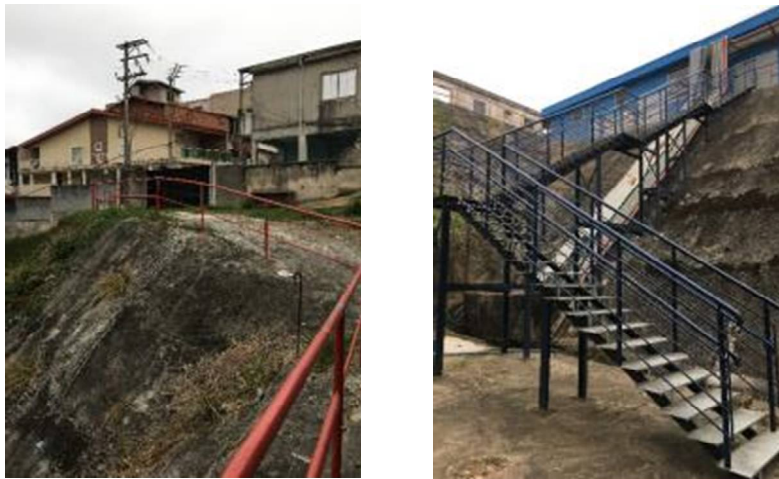
Figura 18: Acesso local com risco ao operador, a escada o acesso direto pela vias locais e à esquerda o acesso pela escada metálica, ambos equipadas com guarda-corpos.
