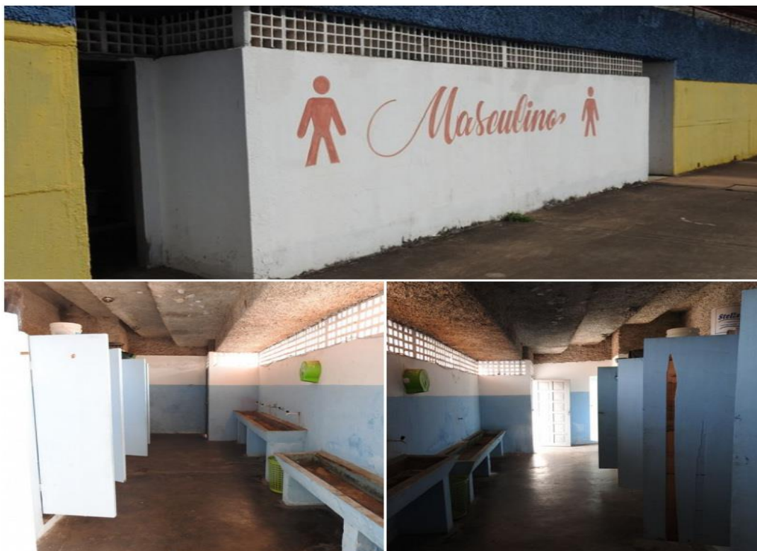
Vista geral do banheiro
