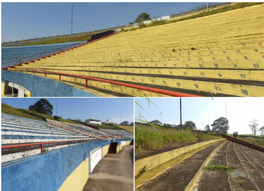
Vista geral da arquibancada
