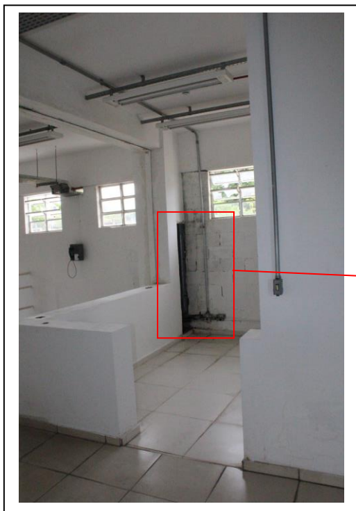
FOTOS 39A / 39B: FALTA DE REVESTIMENTO
