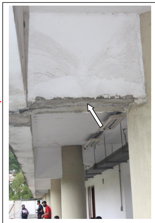
FOTOS 25A / 25B: VIGA SEM REVESTIMENTO
