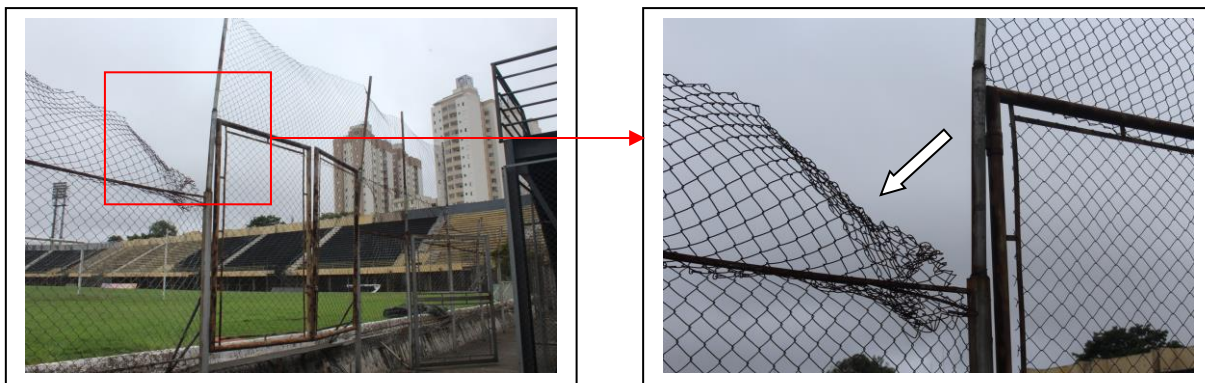
FOTOS 47A / 47B: ALAMBRADO COM DETALHE DA TELA SOLTA
