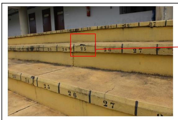
FOTOS 19A / 19B: REVESTIMENTO TRINCADO E QUEBRADO
