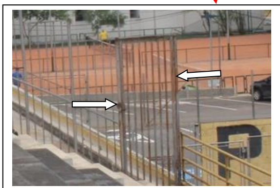
FOTOS 23A / 23B / 23C / 23D: GUARDA-CORPOS LATERAL E FRONTAL E DETALHE DA OXIDAÇÃO
