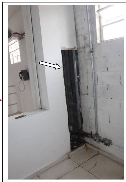
FOTOS 39A / 39B: FALTA DE REVESTIMENTO
