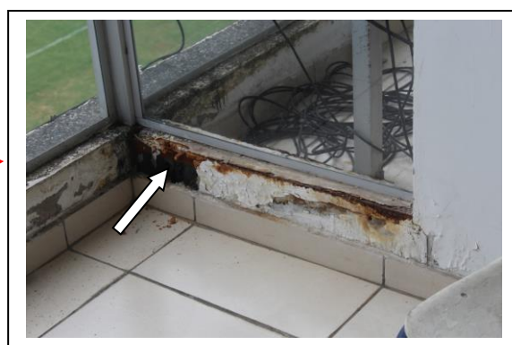
FOTOS 31A / 31B / 31C / 31D: DETALHE MANCHAS DE UMIDADE NA DIVISÓRIA E CAIXILHO ENFERRUJADO
