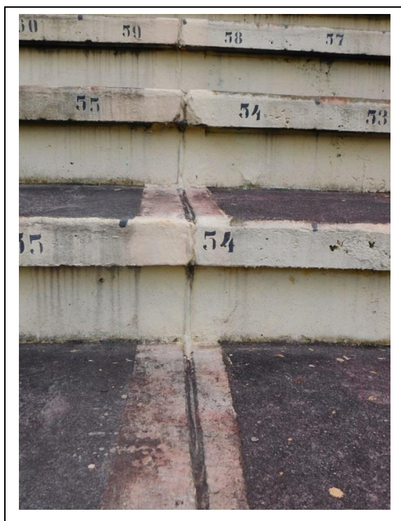
FOTO 3A: JUNTAS DE DILATAÇÃO
