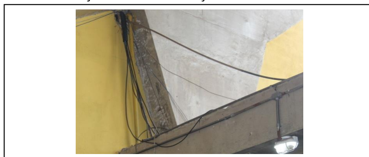
FOTO 247: ALIMENTAÇÃO - SETOR LESTE
