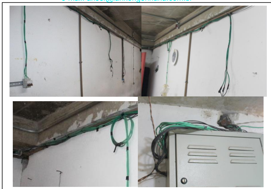
FOTOS 236 A 239: LAVANDERIA
