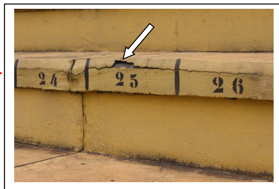
FOTOS 19A / 19B: REVESTIMENTO TRINCADO E QUEBRADO
