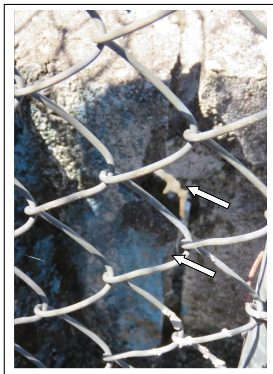
FOTOS 29A / 29B / 29C: GUARDA-CORPO FRONTAL E RACHADURA
