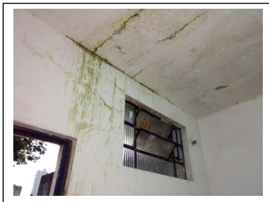
FOTOS 52A / 52B: SINAIS DE INFILTRAÇÃO NO TETO
