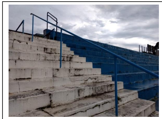
FOTOS 44A / 44B: CORRIMÃO E DETALHE DE PONTOS DESCASCADOS DA PINTURA
