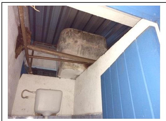
FOTOS 71A / 71B: RESERVATÓRIOS QUE ALIMENTAM OS SANITÁRIOS
