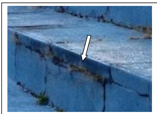
FOTOS 16A / 16B: TRINCAS NOS DEGRAUS E DETALHE DA VEGETAÇÃO
