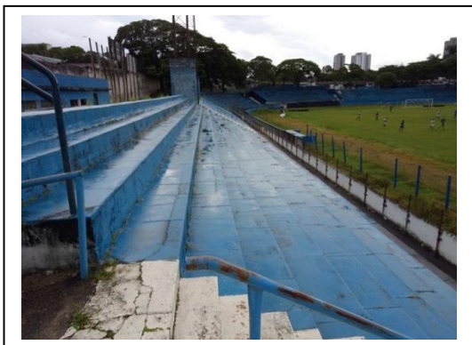
FOTOS 44A / 44B: CORRIMÃO E DETALHE DE PONTOS DESCASCADOS DA PINTURA
