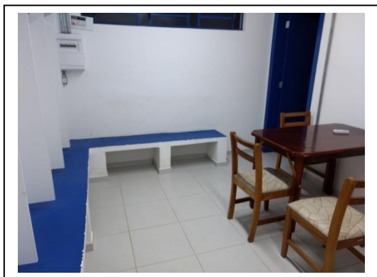
FOTOS 63A / 63B : VISÃO GERAL DO VESTIÁRIO DA ARBITRAGEM
