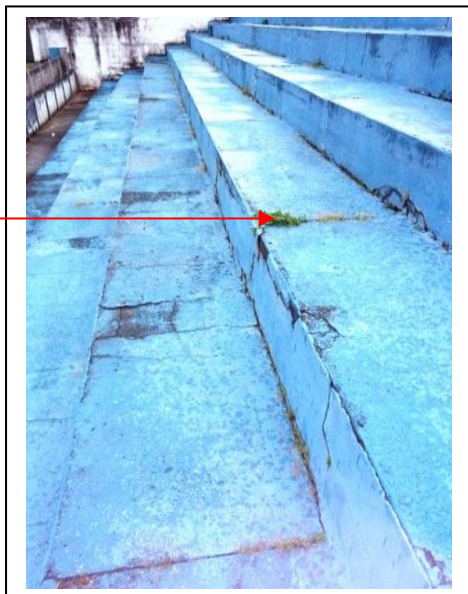
FOTOS 15A / 15B: TRINCAS NO REVESTIMENTO DO DEGRAU
