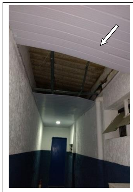
FOTOS 56A / 56B: DESCOLAMENTO DE PLACAS DA COBERTURA
