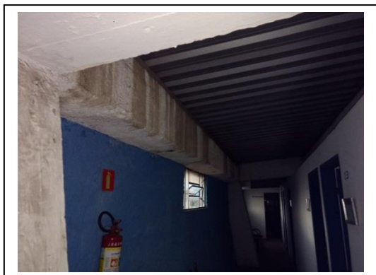
FOTOS 11A / 11B: MANCHAS DE ESCORRIMENTO NA VIGA
