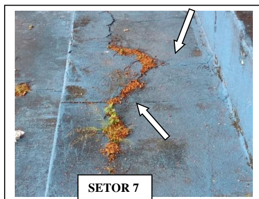
FOTOS 43A / 43B: TRINCAS E REVESTIMENTO QUEBRADO COM VEGETAÇÃO EMERGENTE
