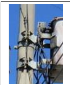
FOTO 106: FERRAGENS EM BOAS CONDIÇÕES DE FIXAÇÃO
