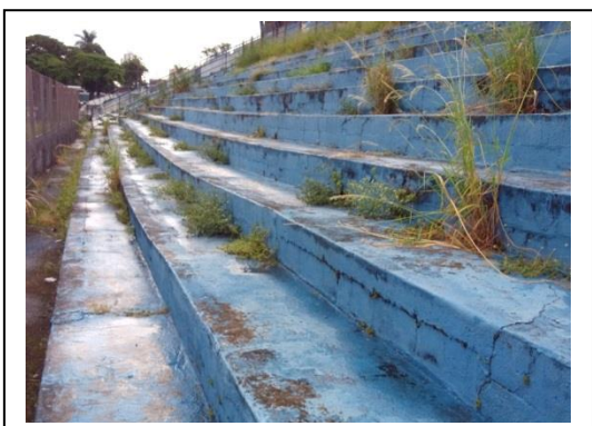
FOTOS 25A / 25B: REVESTIMENTO TRINCADO
