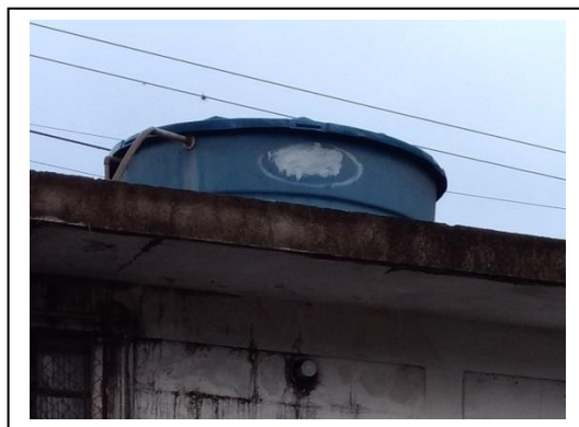
FOTOS 71A / 71B: RESERVATÓRIOS QUE ALIMENTAM OS SANITÁRIOS
