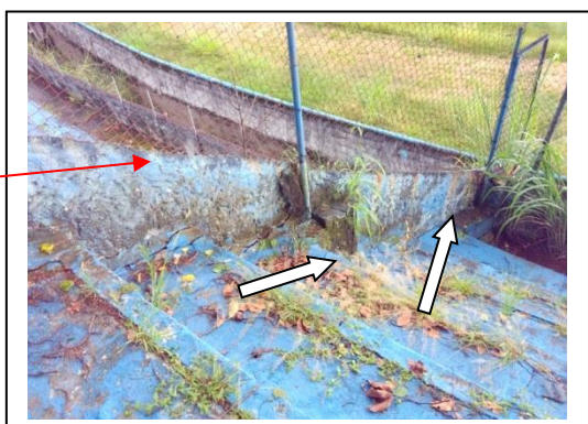
FOTOS 27A / 27B: RACHADURAS NO REVESTIMENTO E REGIÃO ABAUADA
