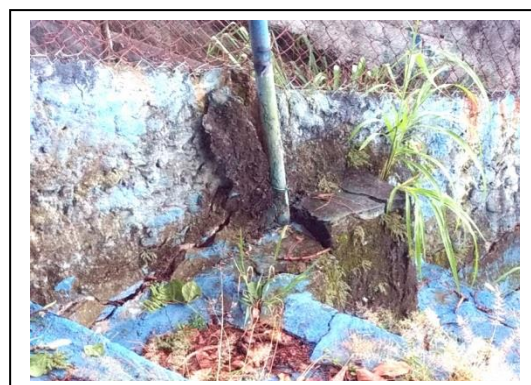
FOTOS 27A / 27B: RACHADURAS NO REVESTIMENTO E REGIÃO ABAUADA
