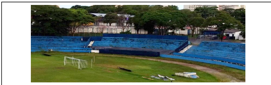
FOTO 233 – SISTEMA DE SPDA ARQUIBANCADAS – SETOR 7 E 8
