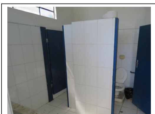
FOTOS 70A / 70B: SANITÁRIO MASCULINO E FEMININO – SETOR 8
