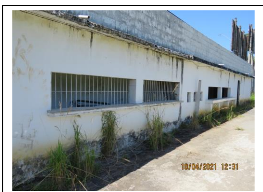
FOTOS 46A / 46B: MANCHAS NO REVESTIMENTO E VEGETAÇÃO EMERGENTE NO PISO
