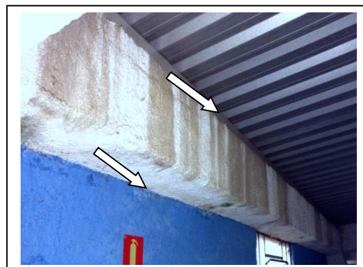
FOTOS 11A / 11B: MANCHAS DE ESCORRIMENTO NA VIGA
