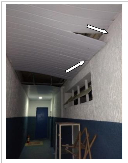
FOTOS 56A / 56B: DESCOLAMENTO DE PLACAS DA COBERTURA
