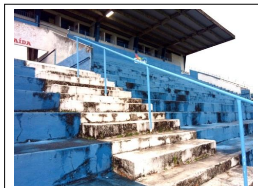
FOTOS 20A / 20B: GUARDA-CORPO FRONTAL E CORRIMÃO
