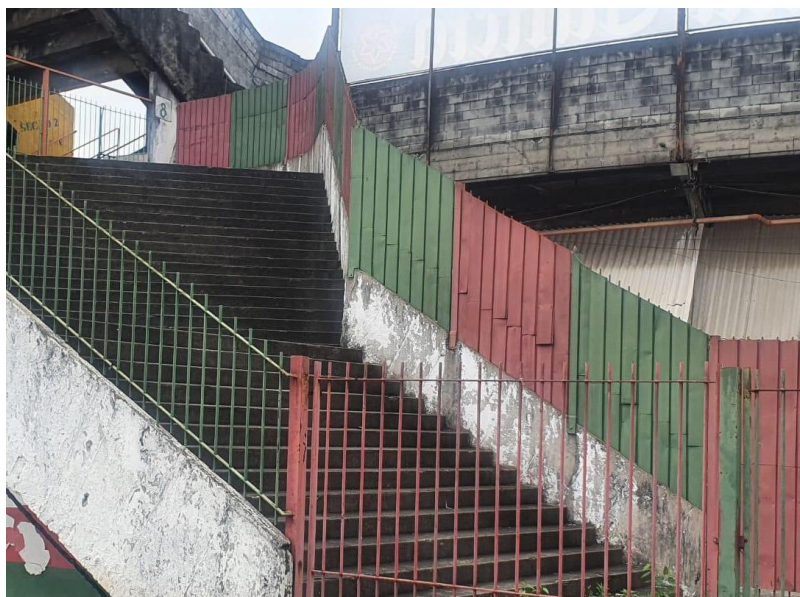
Figura 23: Acesso ao portão 7 (atualmente permanece fechado em dias de jogos)
