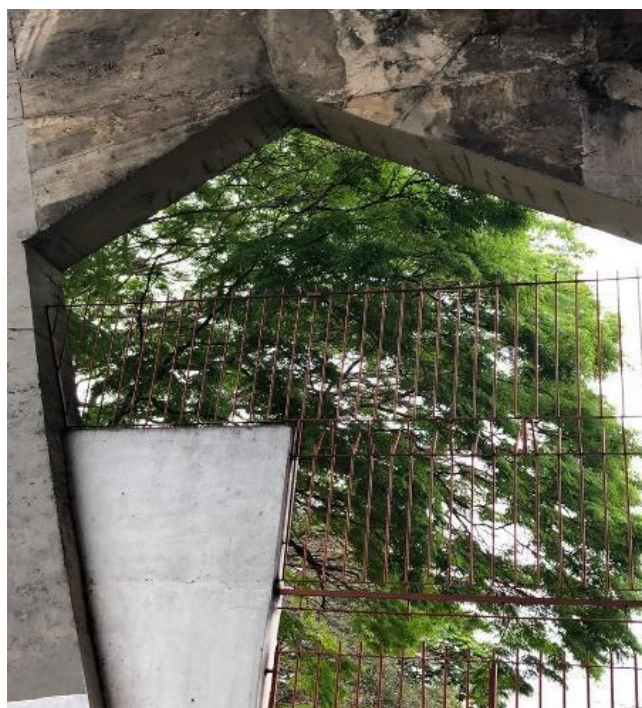
Figura 24: Portão 13 (atualmente permanece fechado em dias de jogos)
