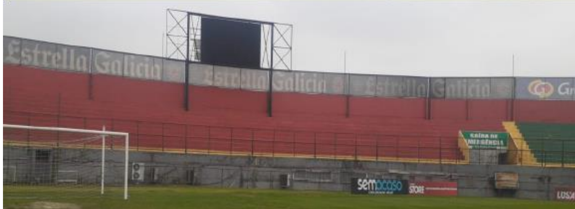
Figura 15: Setores 8 e 9 (Arquibancada Inferior)
