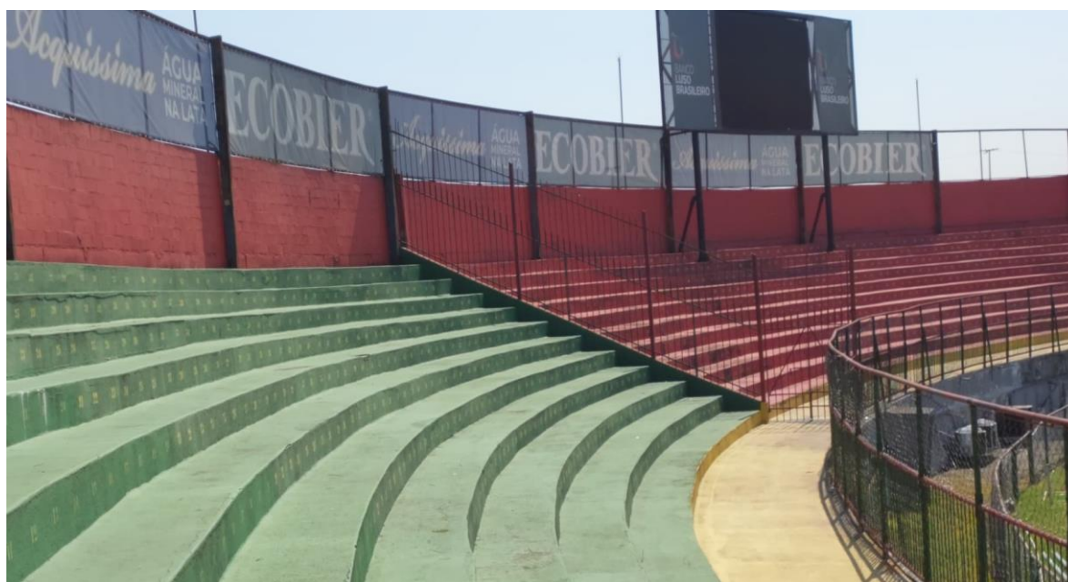
Figura 13: Divisão de torcida. Proximidade com a torcida local
