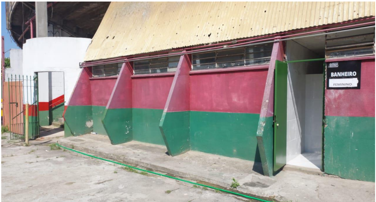
Figura 40: Novos banheiros (Portão 11)
