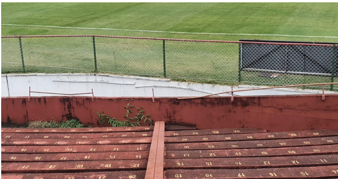
Figura 25: Armação de Ferro solta
