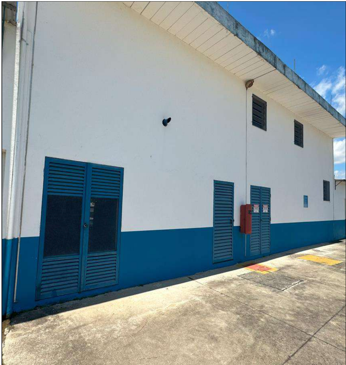
Imagem 22: Isolamento do gerador
