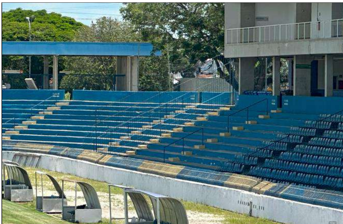
Imagem 15: Grade que separa as arquibancadas do setor mandante
