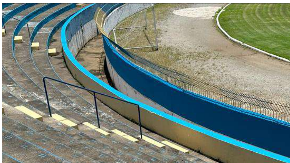
Imagem 20: Grades e fosso de proteção
