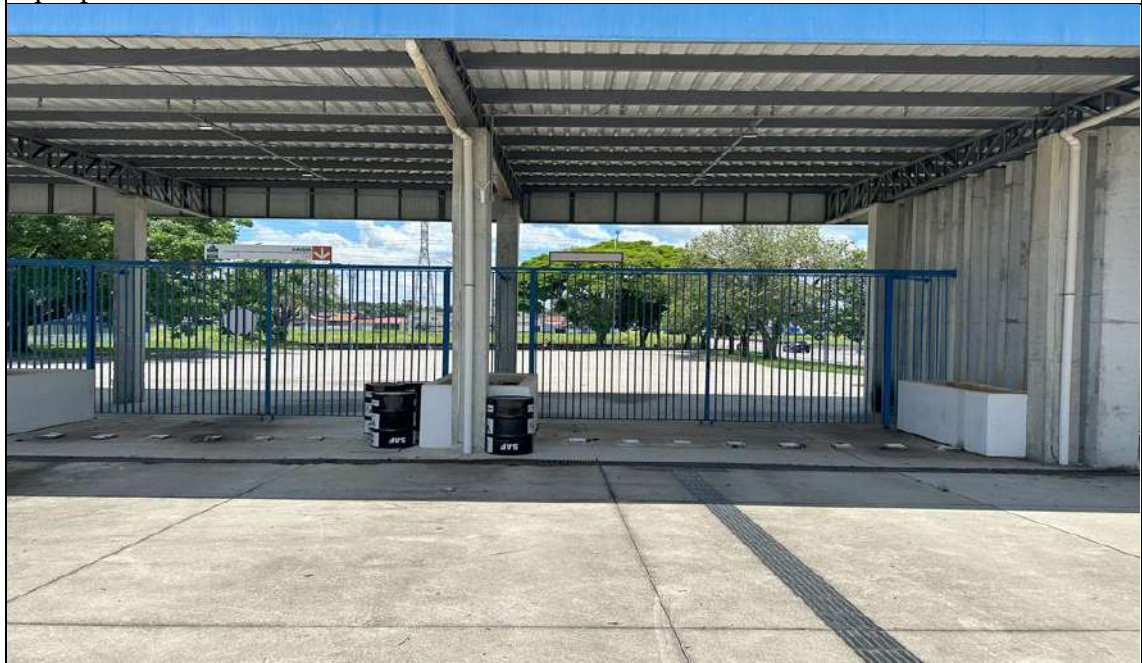
Imagem 4: portão Principal com espaço das catracas removíveis
